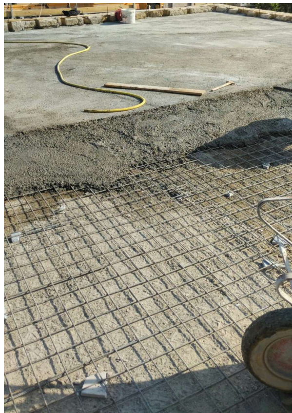
Foto n.6 Rifacimento massetto del lastrico copertura.
