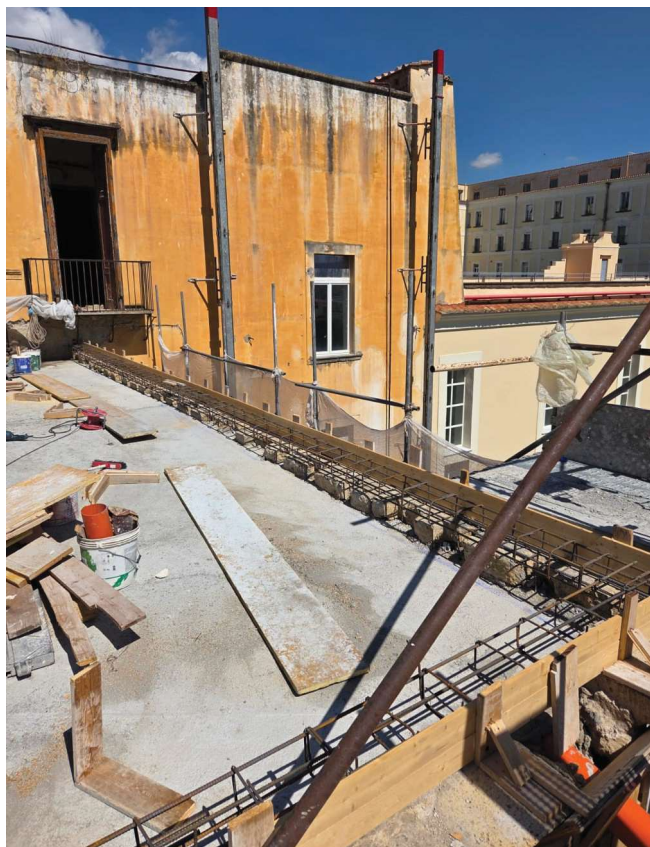
Foto n.5 Ricostruzione cordoli perimetrali del lastrico copertura.
